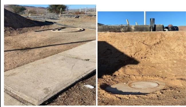
**Imagen N° 11** : Se continua con levantamiento de información, para poder obtener mayor cantidad de datos técnicos, para la confección de Proyecto de Mejoramiento de esta PTAS (Acciona). En esta, se ha encontrado una cámara de registro, en la cual se podrá instalar medidor de caudal para mediciones de caudales de aguas tratadas.
