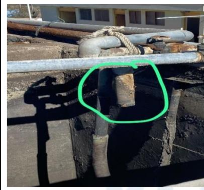
**Imagen N°9** : a raíz del trabajo de retiro de lodos, se produce una falla en bba de recirculación de lodos, la cual pudo ser levantada por operador con apoyo técnico. Se observa que en esta línea falta habilitar bba de recirculación N°2, la cual debería estar disponible ante alguna falla del equipo N°1. Se revisara estado de este equipo.
