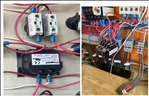
**Imagen N° 10** : En tablero eléctrico, se han producido fallos de desconexión y operación de protecciones. Debido al mal estado que este tiene. Se realizará mantención preventiva, a la espera de poder realizar un mejoramiento mayor a instalaciones eléctricas.
