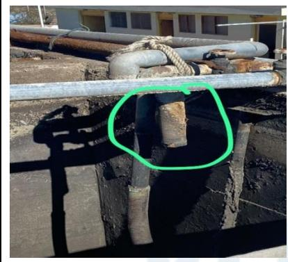
**Imagen N°9** : a raíz del trabajo de retiro de lodos, se produce una falla en bba de recirculación de lodos, la cual pudo ser levantada por operador con apoyo técnico. Se observa que en esta línea falta habilitar bba de recirculación N°2, la cual debería estar disponible ante alguna falla del equipo N°1. Se revisara estado de este equipo.
