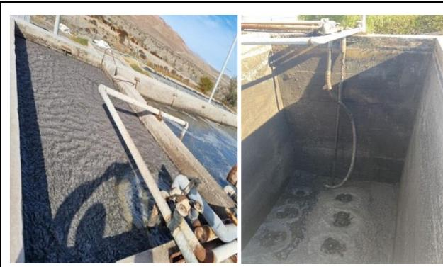
**Imagen N°8** : se coordina con operador, que proceda con el retiro de lodos desde digestor, cuya operación se cumple, quedando digestor con disponibilidad para recibir lodos desde reactor biológico.
